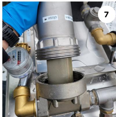
Nehmen Sie das Kerzenfiltergehäuse langsam mit den Händen ab.
